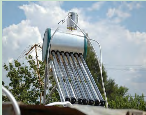
'n Nabyskoot van 'n sonkragwaterverwarmer.
