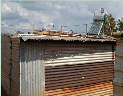
'n Sonkragwaterverwarmer bo-op 'n sinkhuis.
