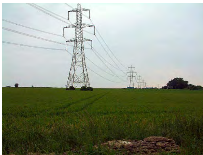
Die nasionale kraglyne vervoer elektrisiteit vanaf die kragstasies regoor die land.
