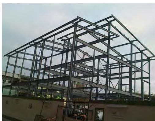
'n Gebou onder konstruksie. Jy kan die staalraamwerk sien.
