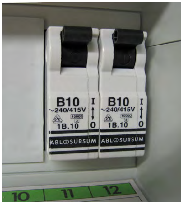
'n Voorbeeld van stroombrekers met skakelaars.
