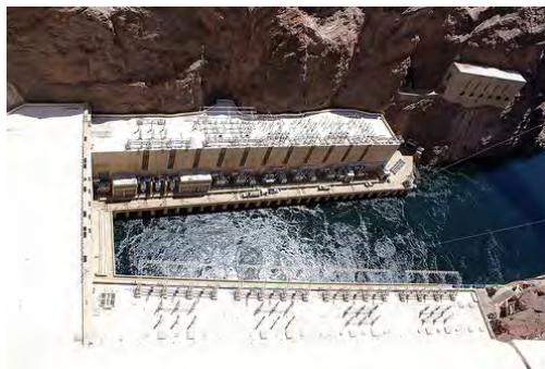
Die water vloei dan by die onderkant van die kragstasie uit, en vloei verder in die rivier af.
