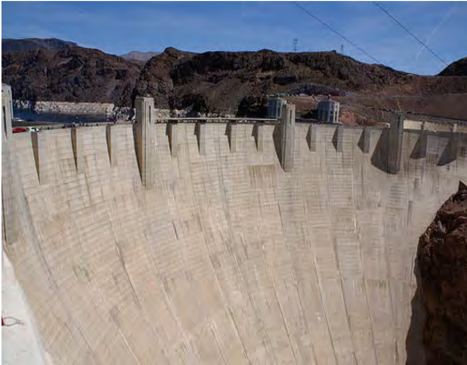
'n Groot damwal met 'n hidroëlektriese kragstasie.
